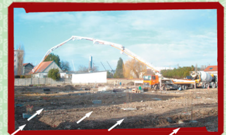
Les têtes des fondations (pieux). La profondeur de chaque pieu dépasse les 14 mètres.
